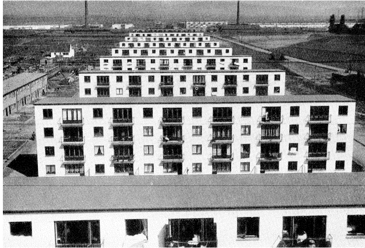
Abb. 23: Siedlung Frankfurt Westhausen. Diese war die letzte gebaute Großsiedlung des neuen Frankfurt.
